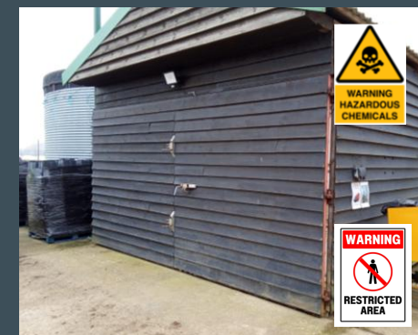
Насосная станция для удобрения
