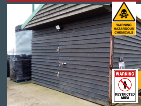
Stacja pompowania nawozów
