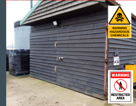
Помпена станция за торене
